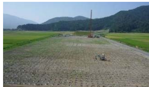
写真 3 向笠地区における PBD 施工状況
